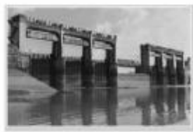
广东北江西河第一闸（1921年建）
