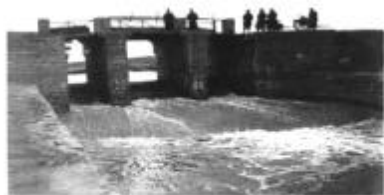
江苏通州区墩御港闸(老三门闸,1916年建)
