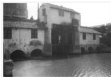
江苏启东市合中闸(1921年建)
