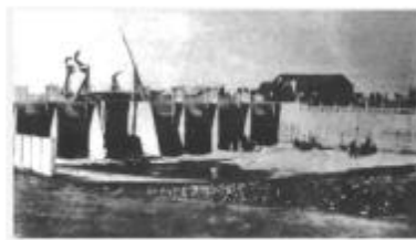
江苏通州区德盈港闸(1919年建)
